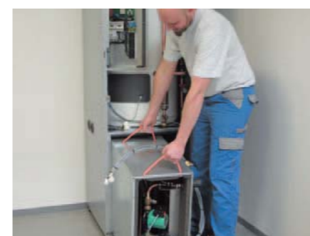
Nasunutí chladicího boxu do tepelného čerpadla.
